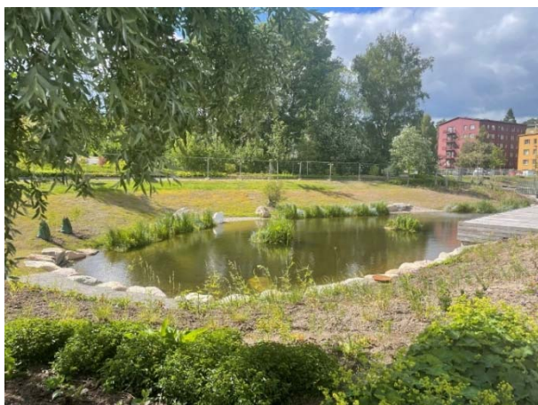
Exempel på en dagvattendamm med sjöstenar, planteringsöar och hängande silverpilar
